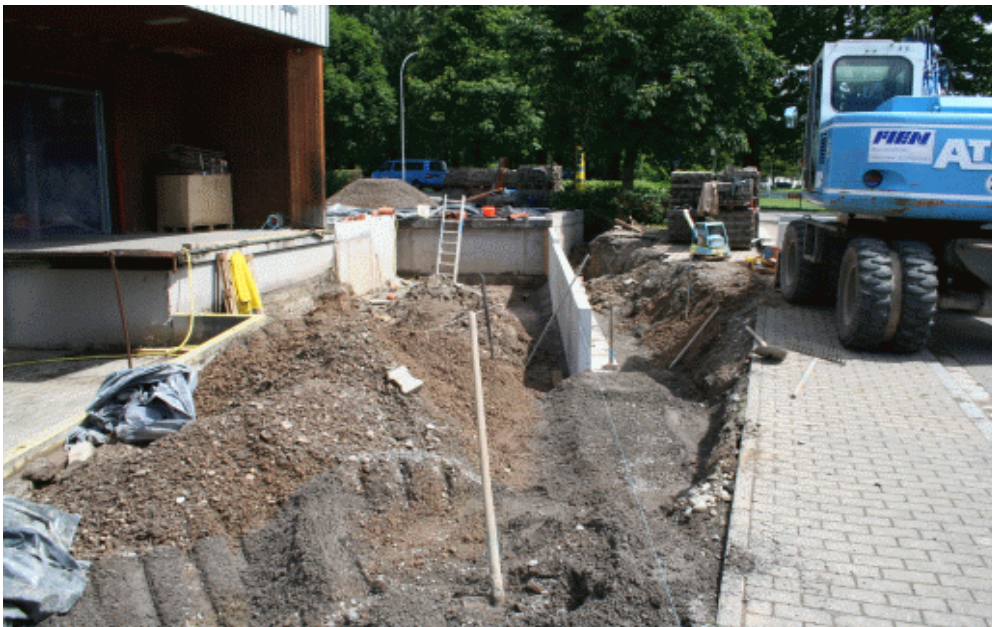
Erweiterung der Rampenanlage am alten Hallengebäude
